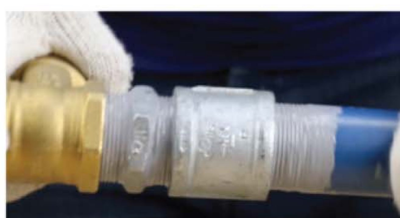
12. ขันท่อโซเลอร์เข้ากับข้อต่อตรง
