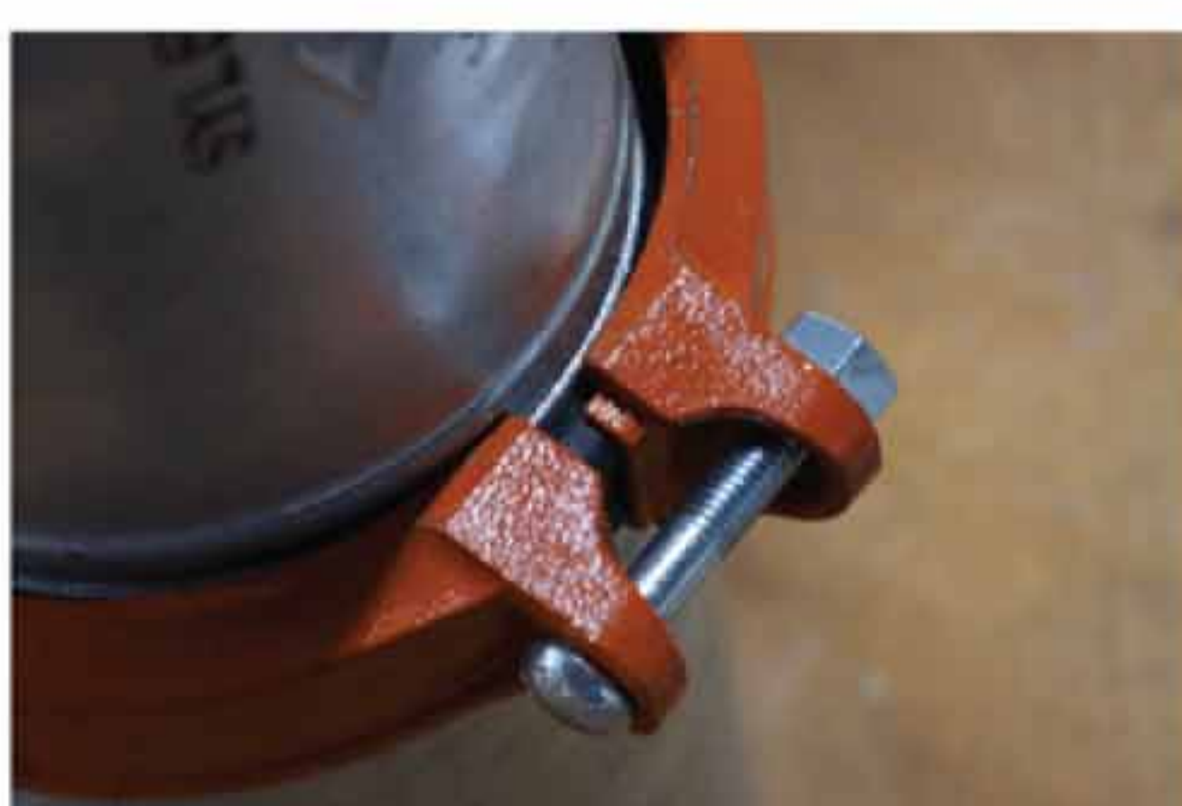
1. ขันนอตสลัก ซ้าย - ขวา ซ้าย - ขวา ซ้าย - ขวา
