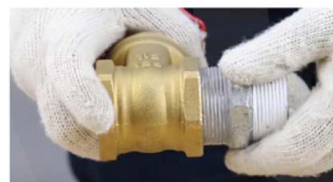
5. ขันข้อต่อนิปปเปิ้ลเข้ากับวาล์วประตูน้ำ หรือ GATE VALVE โดยไม่ต้องรอให้เออร์เมสซีล 55 แห้ง
