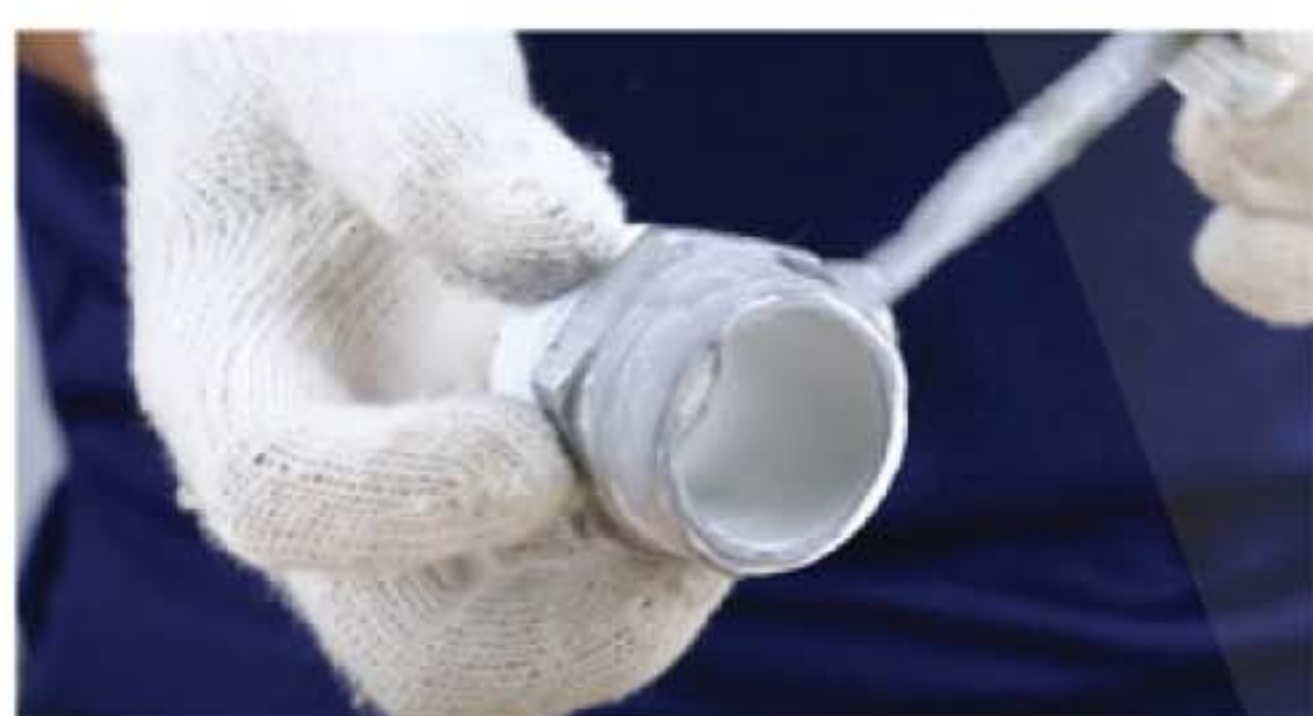
4. ทาเออร์เมสซีล 55 ให้ทั่วเทปพันเกลียวของข้อต่อนิปปเปิ้ล ด้านที่ต้องการประกอบติดตั้ง
